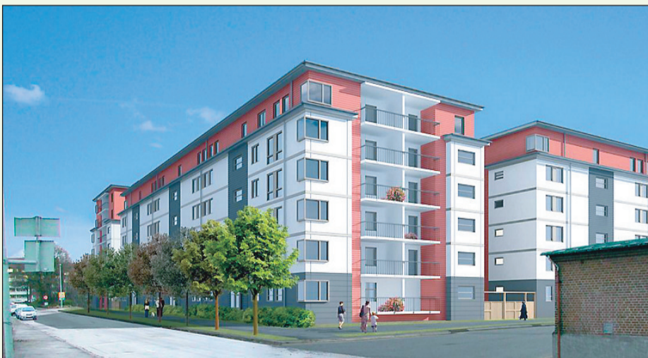
Den pågående byggnationen Portalen på Söder är Helsingborgshems hittills mest genomgripande miljö satsning. Illustration: Helsingborgshem
