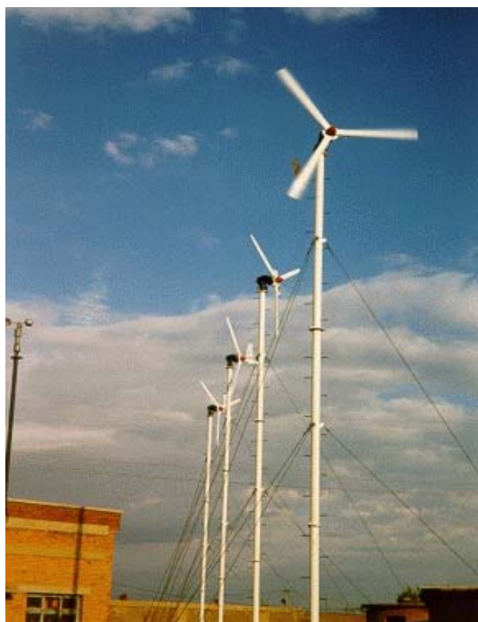
Fig 2.7 Bilde samt produktdata over liten vindturbin plassert i boligfelt. Data gjelder pr. turbin. Oppgitt effekt (max power) er ved den optimale vindhastigheten (her 11 m/s). Ved kraftigere vind, begynner systemet å regulere ned.
